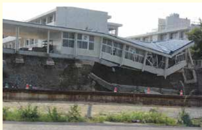
朝倉市立比良松中学校の被災状況
