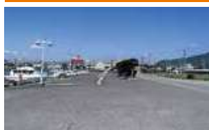
第2船渠内港岸壁5号岸壁
