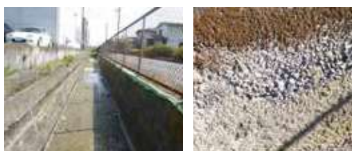
治長請所開渠 摩耗の進行 開渠 標準断面図
