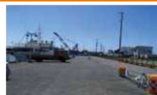
第2船渠内港岸壁2号岸壁
