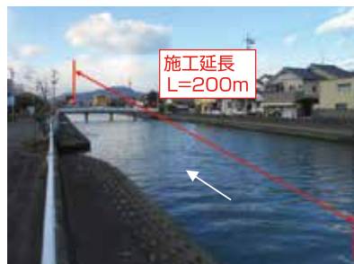
掘削箇所（下流から）
