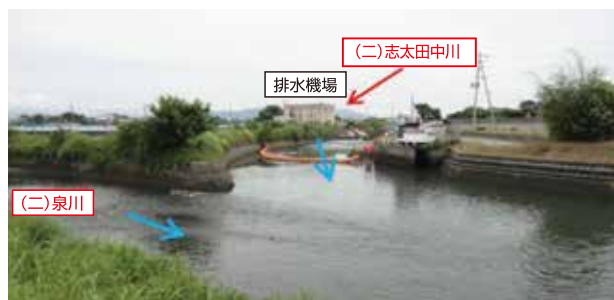
起点より上流を望む
