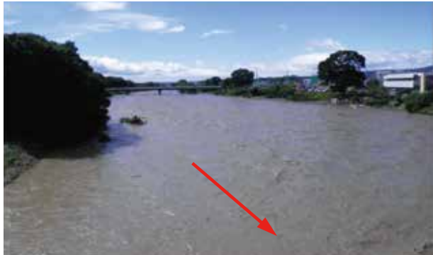
平成26年台風18号出水状況あかつき大橋より上流を望む
