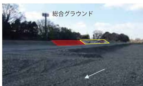
施工箇所（下流から）
