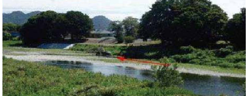
土砂堆積状況
