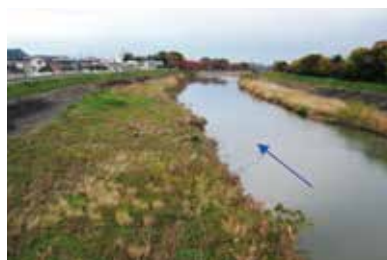
堆積状況（高草橋下流）
