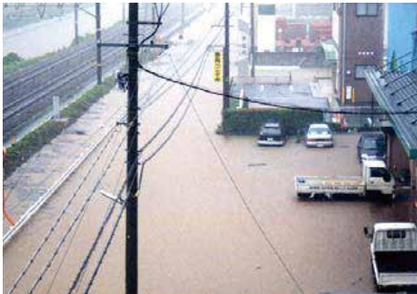
浸水状況（斎場）（H16.6豪雨）
