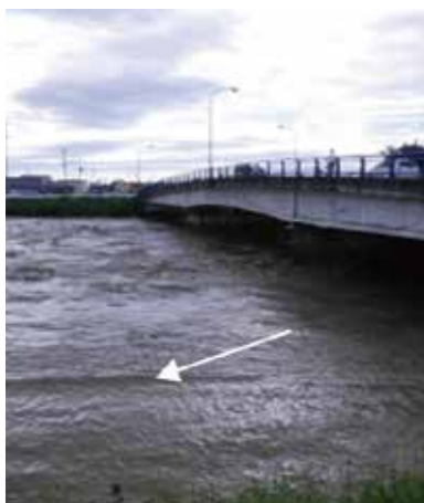
出水状況（豊田橋下流）
