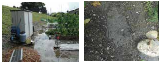
台風18号鴻益橋上流左岸漏水状況 台風18号鴻益橋上流左岸漏水状況
