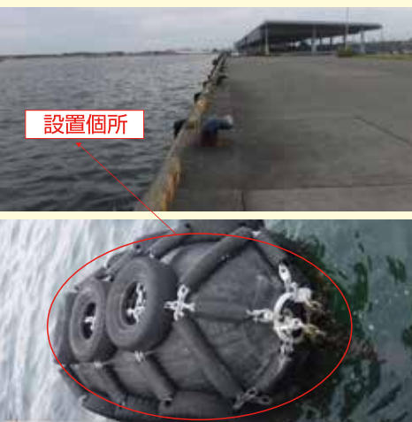
空気式防舷材1200*2000 船1隻に対し3基設置
