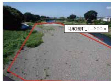
土砂堆積状況及び掘削箇所
