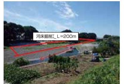
土砂堆積状況及び掘削箇所
