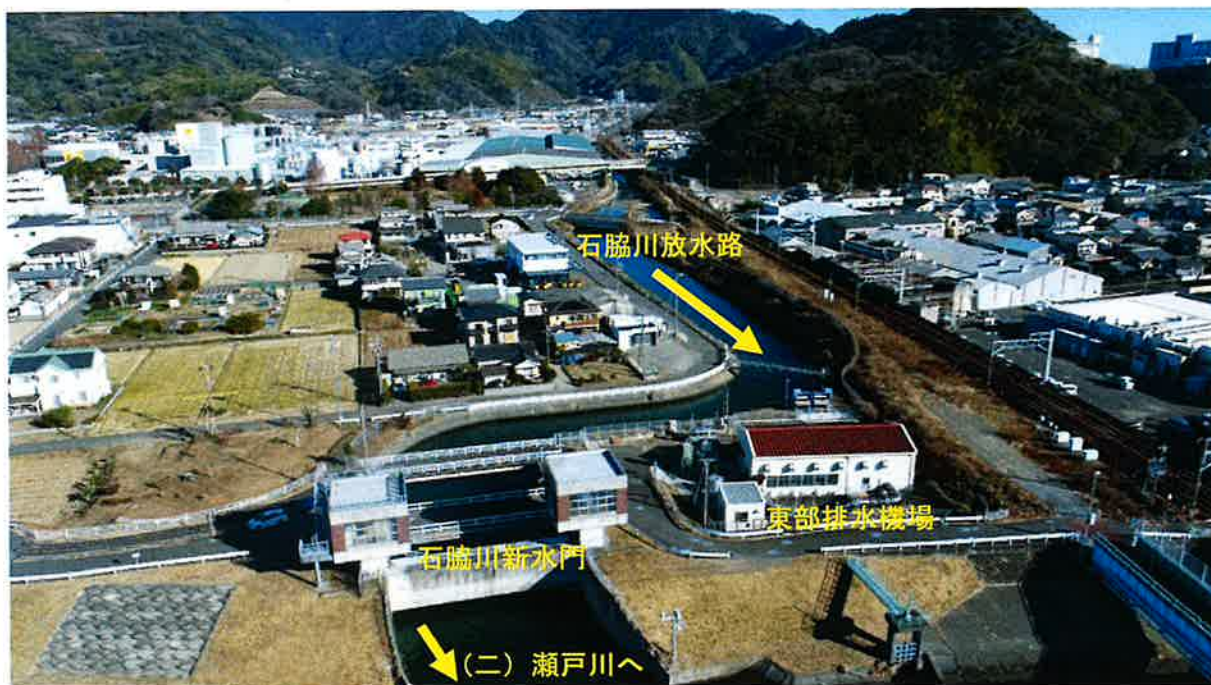
石脇川新水門・東部排水機場（岡当目）
